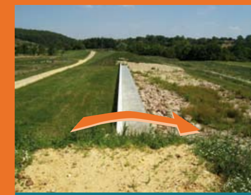
Le déversoir laisse passer les eaux quand le niveau d'eau est trop élevé.
