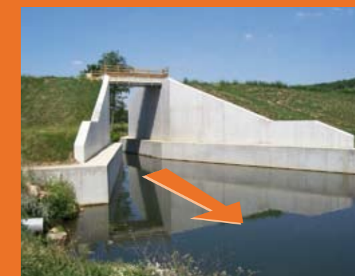
Le pertuis limite le débit d'écoulement des eaux.
