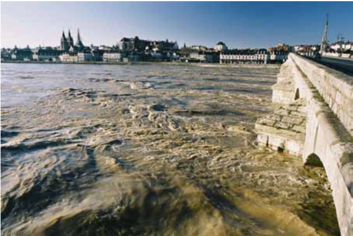
Crue de la Loire à Blois (décembre 2003)
