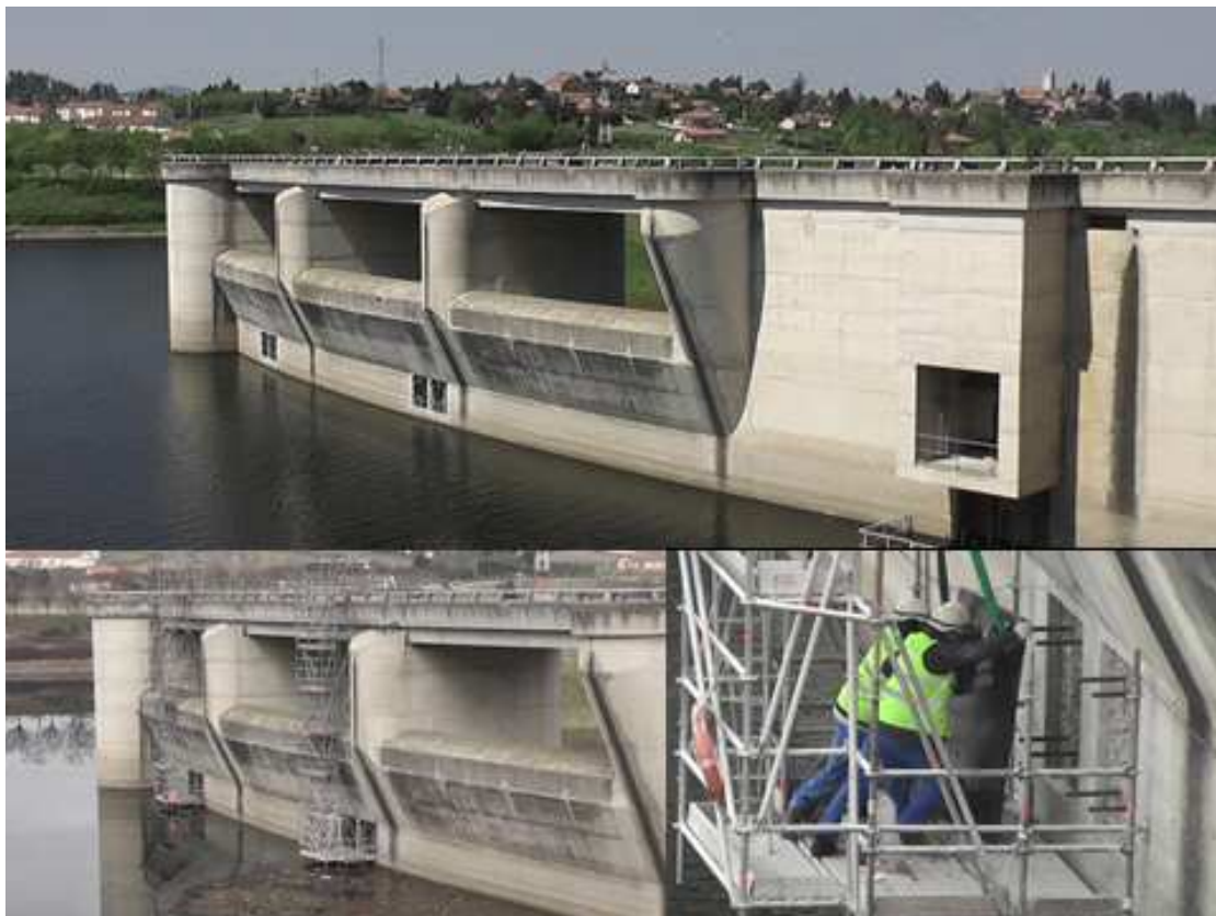
Pose des platines
