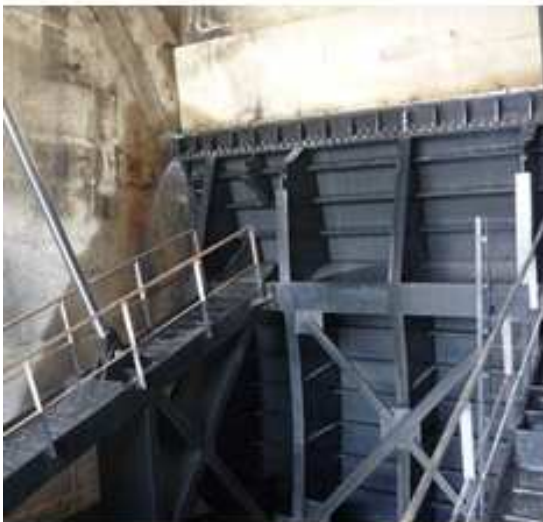
Vanne VS2 APRÈS réparation et enlèvement du batardeau
