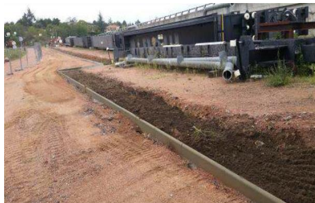
Terrassement, pose des bordures et mise en place de la terre végétale
