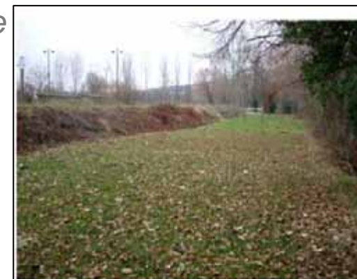
Digue bordure de Veyre- stade
