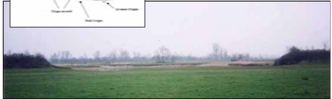
Remblais ou digues longitudinales
