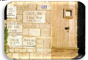
Repères de crues
