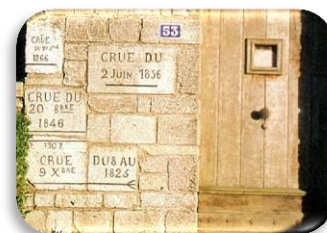
Repères de crues
