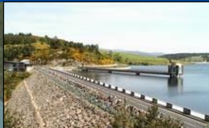
barrage en enrochement d'une hauteur de 50 m
