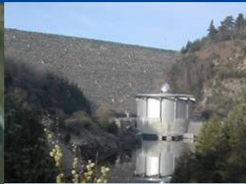
usine de pompage-turbinage
