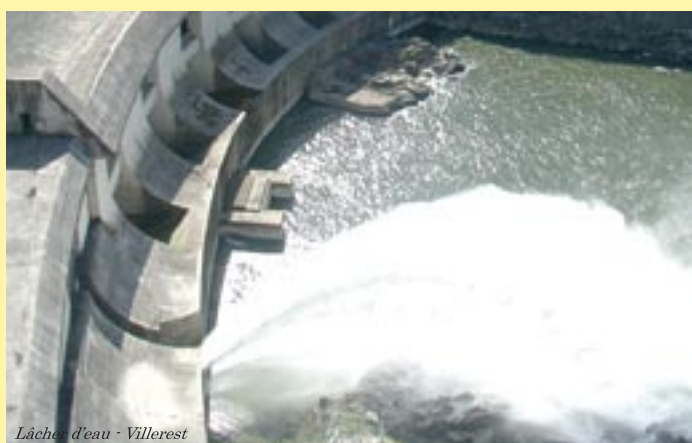
Lâches d'eau - Villerest
