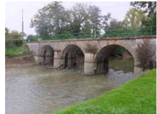
Pont en amont
