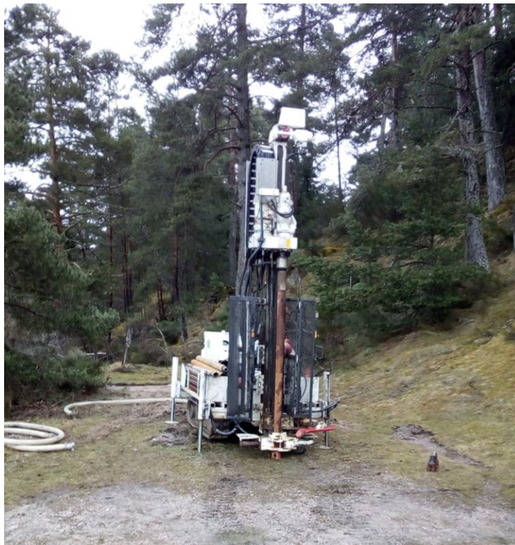
Photo de forage durant la campagne d'investigation géotechnique
