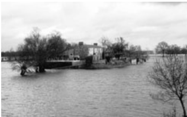
Fig. 4-5a et b. Avant et pendant l'inondation.
