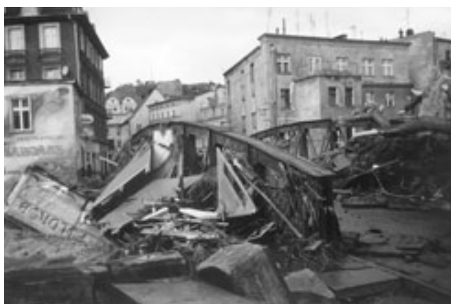
Fig. 3-3. Dégâts dus à l'inondation à Klodzko (cliché D. Kicyla).
