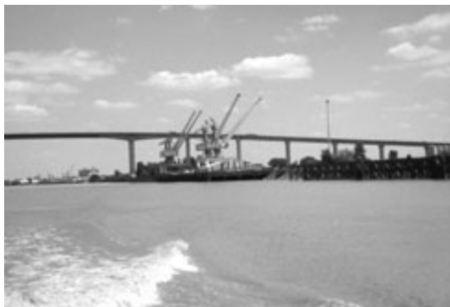
2-6c. La Loire de l'estuaire (cliché agence de l'eau Loire-Bretagne).
