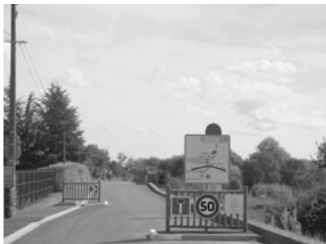
Fig. 5-15. L'accès à la levée de Belle Poule, côté ouest.
