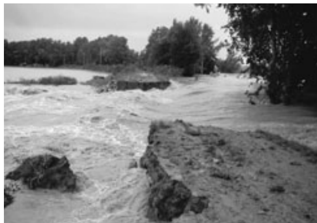
Fig. 2-3. Brèche sur une digue du Vidourle (Gard), le 8 septembre 2002 (cliché G. Degoutte).
