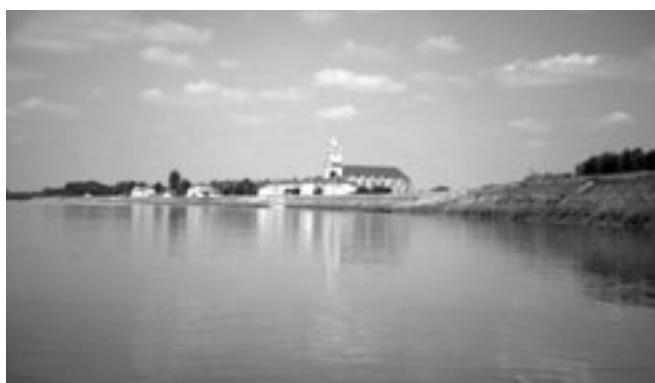
Fig. 4-10. Sur les rives plates, les villages s'appuient à la levée. Exemple de La Bohalle (49).
