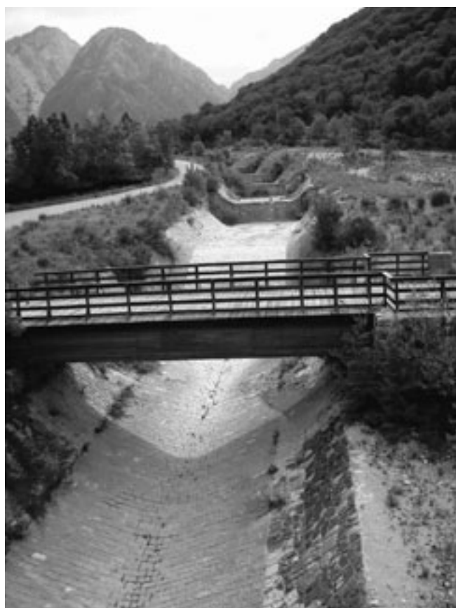
Fig. 3-22. Canal d'évacuation des crues du Tagliamento.
