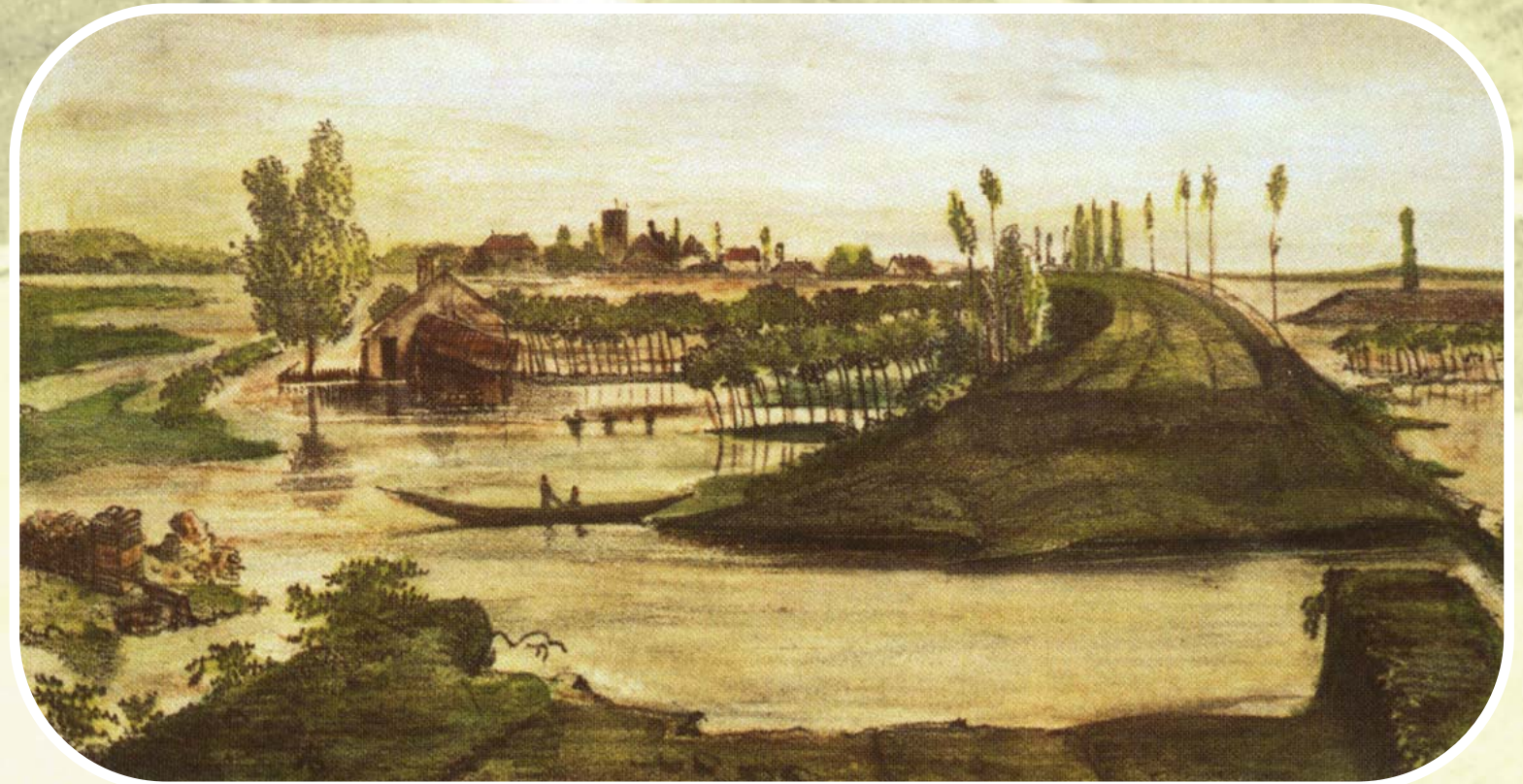
Brèche de la levée de Saint-Pryvé après une inondation
