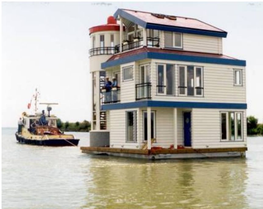
Photo 6.1: les maisons flottantes n'obstruent pas l'écoulement des eaux; des maisons qui ne flotteraient que pendant les périodes de hautes eaux peuvent même être construites !
