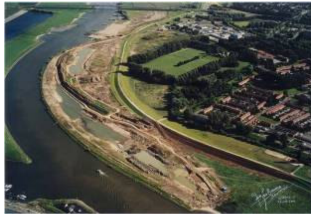
Photo 3.7 : déplacement de digue dans le Niederrhein près d'Arnhem.
