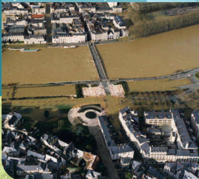
Angers - Pont de Verdun - Crue de janvier 1995
