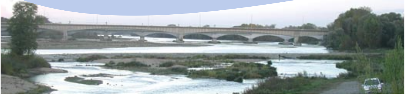
Ponts et anciens ouvrages de navigation influencent la Loire dans la traversée d'Orléans.
