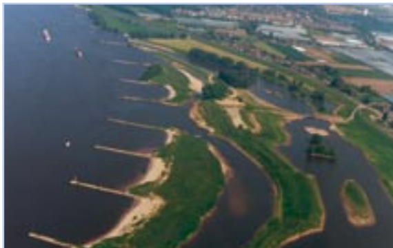
Contribution du lit majeur à l'écoulement d'une crue. (Gameren, Pays-Bas)
