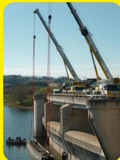
Installation du batardeau et démarrage des travaux de la reprise de l'étanchéité des vannes du barrage de Villerest
