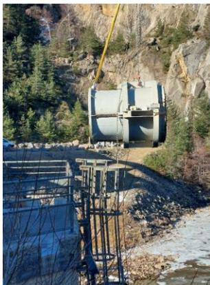
Dépose de la tête du jet creux
