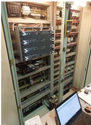
Le DIGIPID 1500 permet de réguler la vitesse de rotation des turbines pour la synchroniser au réseau électrique. Il gère également le démarrage et l'arrêt des groupes.
