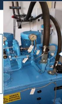
Remplacement des flexibles hydrauliques des vannes
