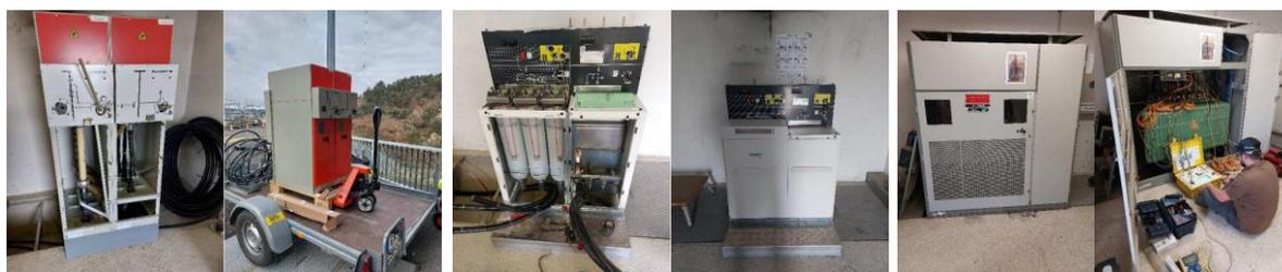
Installation de nouvelles cellules d'arrivée et maintenance du transformateur 20KV / 400V
